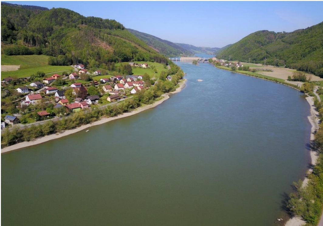
Abb. 159: Donau im Unterwasser des Kraftwerks Jochenstein
