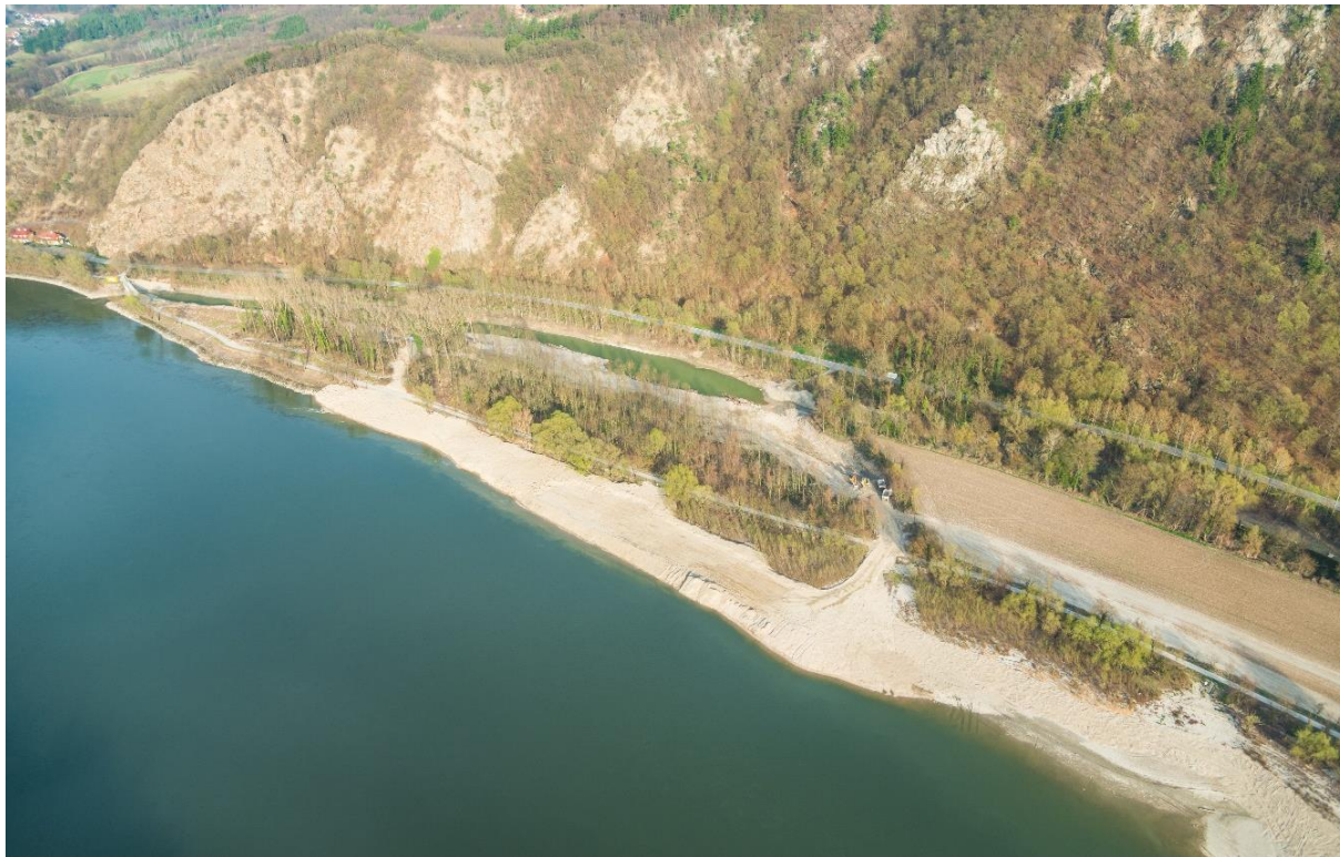
Abb. 151: Ufervorschüttung im Zuge der Entlandung eines Altarms Aggsbach (Donau, Wachau) der anfallende Kies wurde in Form einer Ufervorschüttung im Hauptstrom eingebaut Foto: Haslinger, www.extremfotos.com
