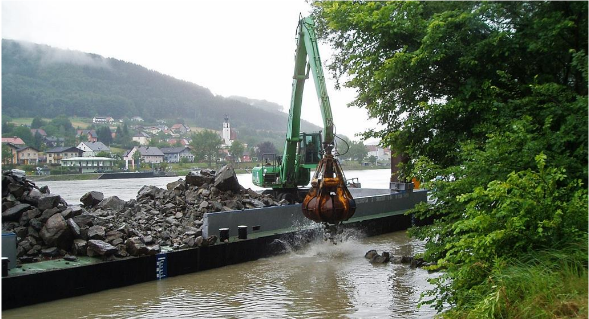
Abb. 167: Einbringen von Kurzbuhnen
