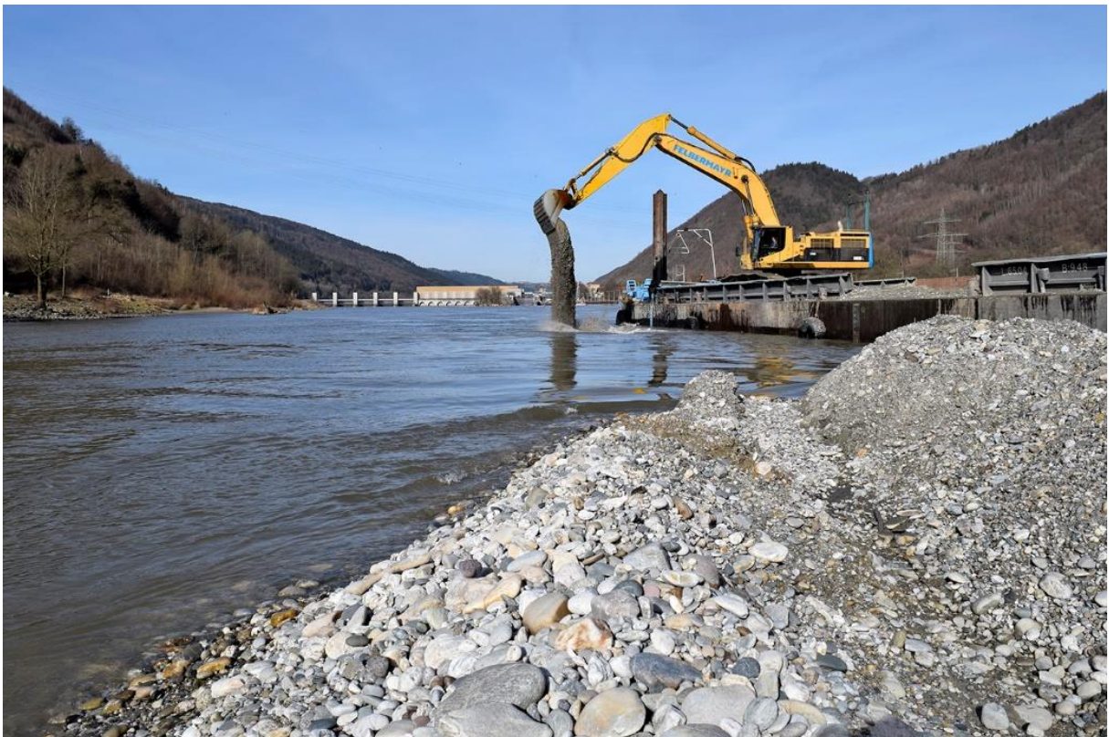
Abb. 150: Einbau von rückgeführtem Geschiebe in Form einer Kiesinsel
