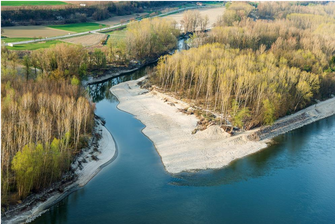
Abb. 155: Trichterförmige Einströmöffnung in den Nebenarm Schallemersdorf (Donau, Wachau)
